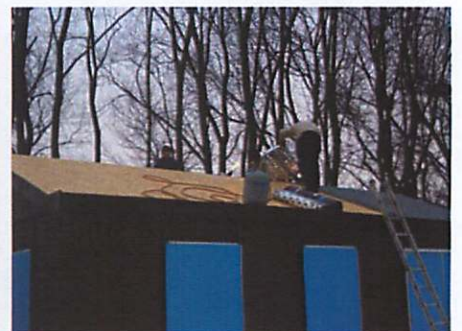
Isolatie plaatsen op het plafond, het dak erop en dakbedekking plakken op het dak.
