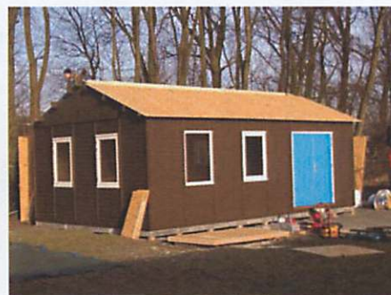
Isolatie plaatsen op het plafond, het dak erop en dakbedekking plakken op het dak.
