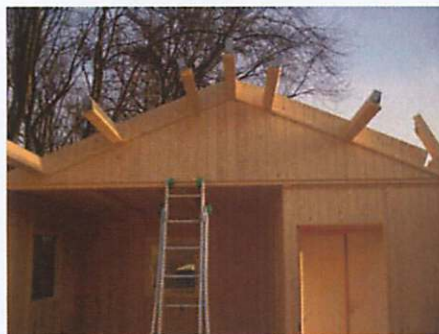
Na de wanden kon het plafond geplaatst worden.
