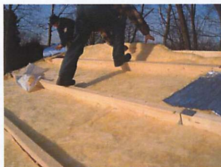
Isolatie plaatsen op het plafond, het dak erop en dakbedekking plakken op het dak.
